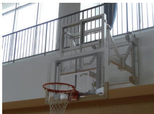
▲水平引込式バスケット台の上下調節式（小学生規格の高さ）
