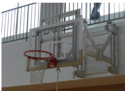
▲水平引込式バスケット台の上下調節式（一般規格の高さ）
