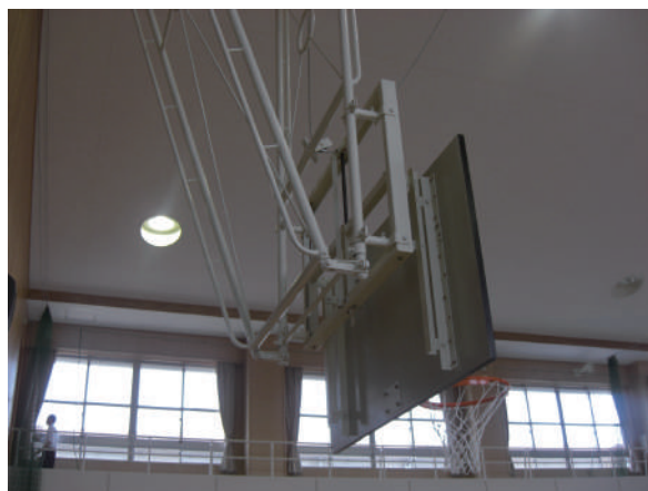
▲巻上式バスケット台の上下調節式（小学生規格の高さ）
